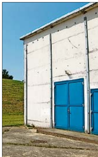
Das Wasserwerk Karow wird stillgelegt. Es hatte sich in den vergangenen Jahren als nicht mehr rentabel erwiesen.
