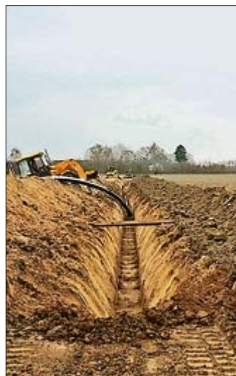
Mit der Verlegung von neuen Rohren besteht nun bald eine sichere Verbindung zum Wasserwerk Plau.
