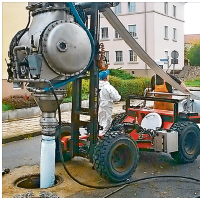
Ein Inliner wird eingesetzt. Sieht futuristisch aus, gehört aber beim Kanalbau zum Alltag.
