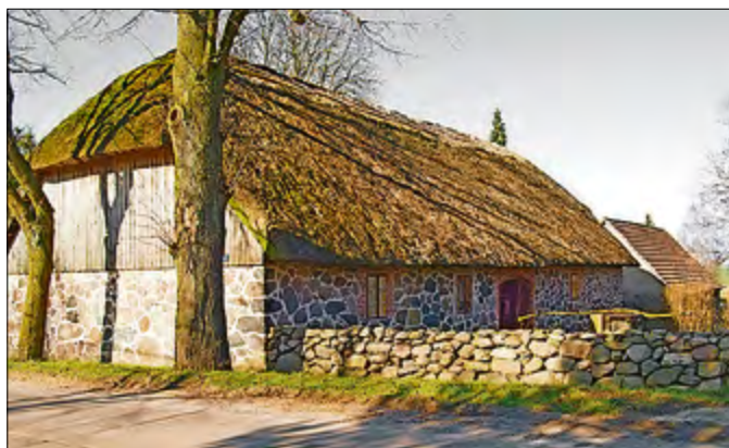
Dem Baustoff Lehm in seiner ganzen Vielfalt hat sich das nach ihm benannte Museum in Gnevsdorf verschrieben.
