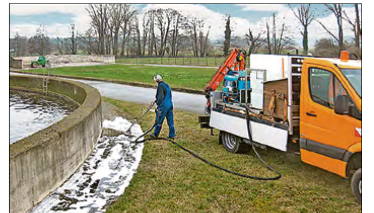
Wasserwerke und Kläranlagen müssen von Wildwuchs freigehalten werden. Ein effektives Mittel ist der Heißwasserschaum, der hier zum Einsatz kommt.
