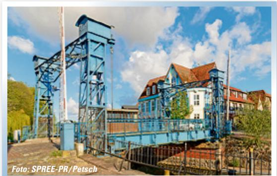
Das deutlich kleinere „Blaue Wunder“ unterfahren Boote, die auf der Elde in Plau unterwegs sind. Seit der Modernisierung der 1916 gebauten Stahlbrücke im Jahr 1991/1992 muss der Schleusenwärter nun nicht mehr von der ein paar Hundert Meter entfernten Schleuse hierher laufen oder radeln, um die Hubbrücke zu bedienen.
