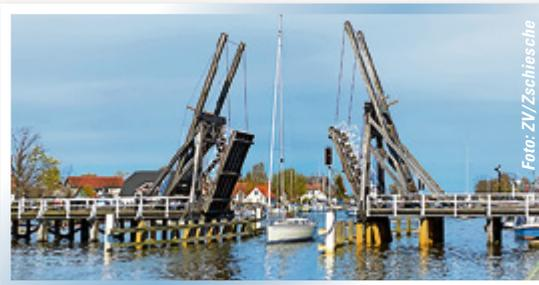
Vor den Toren Greifswalds überspannt in Wick seit 1887 die Doppel-Waagebalken-Brücke das Flüsschen Ryck. Sie wurde nach holländischem Vorbild errichtet. Nach einigen Sanierungen und Wiederaufbauten sind dennoch sowohl ihre Konstruktion als auch die schmiedeeisernen Beschläge erhalten. Die beiden 13,30 Meter langen Klappen des Technischen Denkmals werden heute noch per Hand gezogen.
