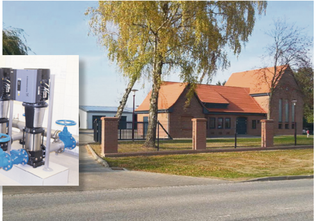
Das historische Wasserwerk Goldberg ist von außen ein echtes Schmuckstück. Innen beeindruckend die großen Pump- und Filteranlagen (kl. Foto) – für Schulklassen ein echtes Highlight. Foto: SPREE-PR/Archiv
