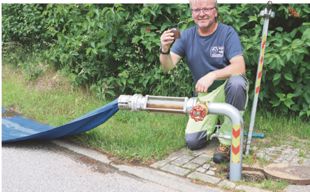
Michael Schwager vom Unternehmen Pohl & Timm begutachtet eine Probe mit deutlicher brauner Färbung. Ist das Wasser am Ende wieder klar, ist die Spülung abgeschlossen.
