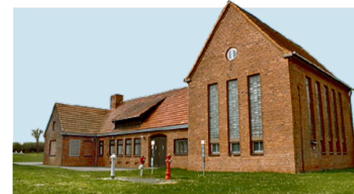
Auch die Effizienz der Pumpen im Wasserwerk – hier in Goldberg – steht im Kennzahlenvergleich auf dem Prüfstand.
