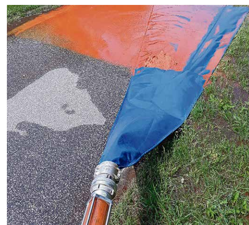
▲ Ein Kompressor "schießt" das Luft-Wasser-Gemisch durch die Rohre. ▼ Das erste Spülwasser ist häufig rostbraun (Foto links). Am Ende der Reinigung läuft klares Wasser durch den Kontrollzylinder.
