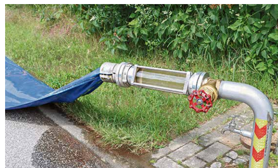
▲ Ein Kompressor "schießt" das Luft-Wasser-Gemisch durch die Rohre. ▼ Das erste Spülwasser ist häufig rostbraun (Foto links). Am Ende der Reinigung läuft klares Wasser durch den Kontrollzylinder.
