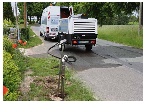
▲ Ein Kompressor "schießt" das Luft-Wasser-Gemisch durch die Rohre. ▼ Das erste Spülwasser ist häufig rostbraun (Foto links). Am Ende der Reinigung läuft klares Wasser durch den Kontrollzylinder.
