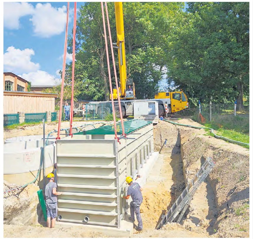
In diesem „Kasten“ befinden sich drehbare Scheiben für die biologische Klärung. Foto: WAZV
