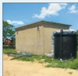
bisher insgesamt 263.000 Euro investiert. Seit dem Abriss der alten Reinwasserbehälter im vergangenen Jahr wird die Versorgung über einen provisorischen transportablen Reinwasserbehälter mit einem Fassungsvermögen von 10 m<sup>3</sup> sichergestellt. Der letzte Bauabschnitt wird, sofern die Witterung das zulässt, nach Ausschreibung im Frühjahr 2013 begonnen und in Abhängigkeit vom
